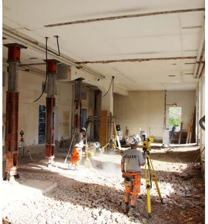
Der neue Mehrzwecksaal im alten Ost-Trakt nimmt Form an
